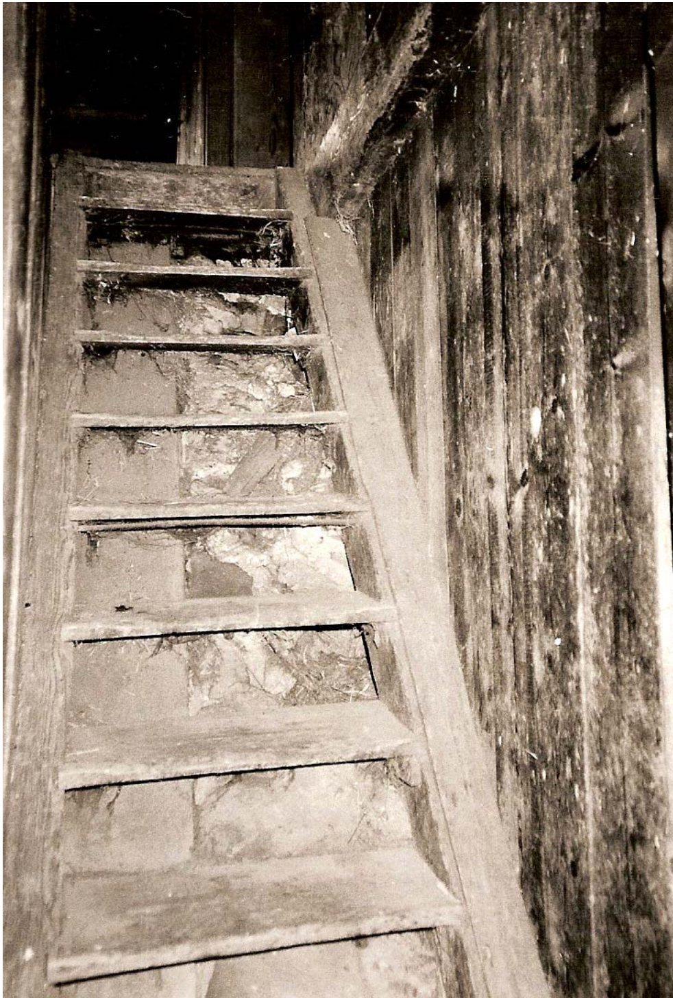
Les escaliers conduisant de la cuisine aux chambres du haut, construit probablement au début du XIXe siècle, en même temps que la plus ancienne des deux chambres.
